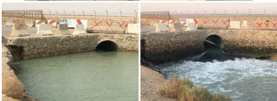
نگاره ۲: تصویر اشل‌های مستقر در پل لوله و پادگان سپاه
