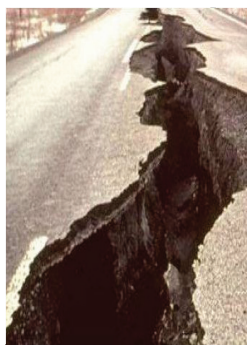
نگاره (۲) و (۳) نشست زمین در مناطق مختلف بر اثر برداشت بی‌رویه آب‌های زیرزمینی
