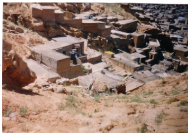
(نگاره ۵) استقرار نادرست خانه‌ها بر روی شیب گسلی - تبریز - احمدآباد (منبع: م.زارع ۱۳۸۶)
