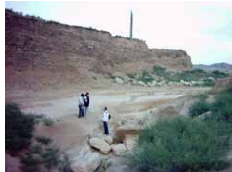
نگاره (۴): نمایی از خندق‌های بوجود آمده در کف رودخانه چناراهدار
