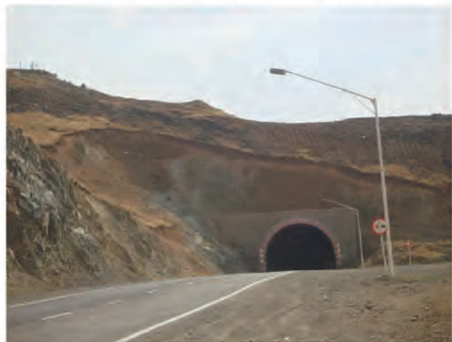
نگاره (۲) لغزش چرخشی در دهانه تونل مسیر سندج - دهگلان
