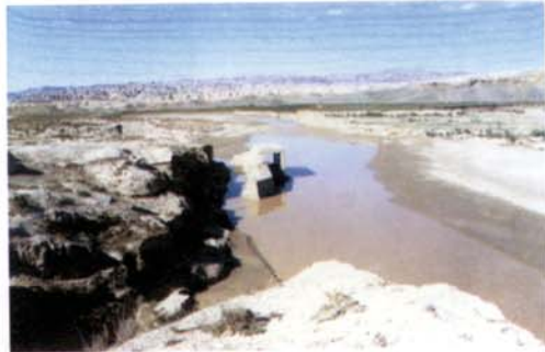
نگاره (۹): تخریب ایستگاه پمپاژ در یکی از شاخه‌های اترک
